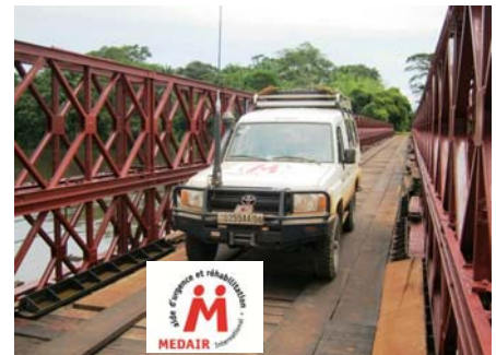
Pont bailey sur la rivière Bomokandi avant et après intervention de Medair (réparation du platelage, des sommiers et boulons manquants, des traverses tordues)
